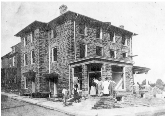
Costruzione casa Lorenzon a Chestnut Hill, Pennsylvania, nel 1908
