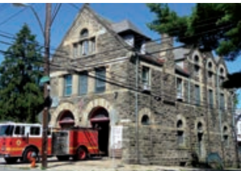
Sede dei vigili del fuoco
