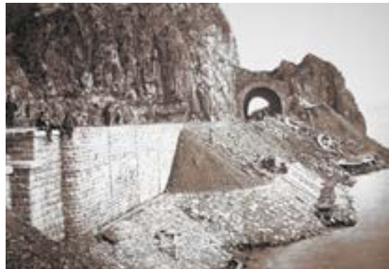
Muro di contenimento della ferrovia - 1904
