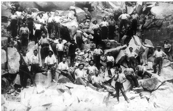
Operai in una cava di pietra ad Hattingen (Germania) inizio '900 Cortesia L'Artugna
