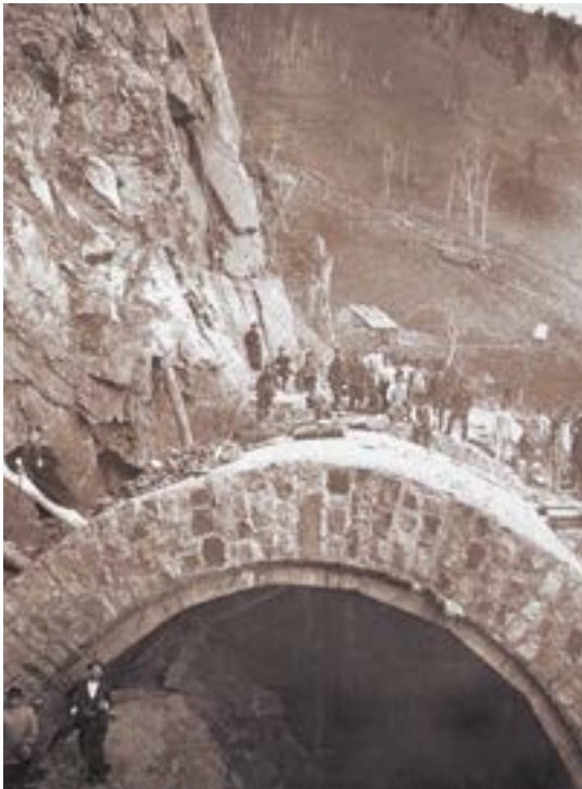
Dettaglio lavori su una volta di un tunnel della Transiberiana - 1904
