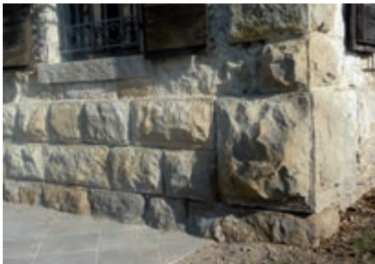
Particolare delle pietre d'angolo del basamento della casa Lorenzon a Poffabro
